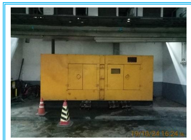
รูปที่ 2.9-1 เครื่องกำเนิดไฟฟ้าสำรองภายในโครงการ
