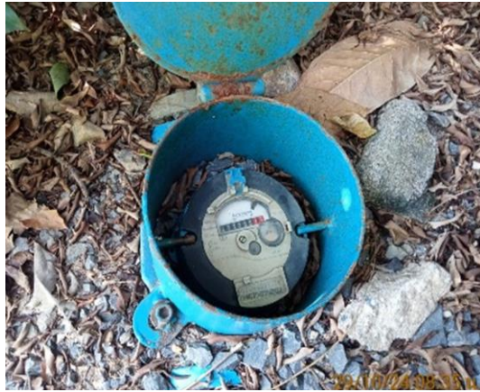
รูปที่ 3-16 จุดติดตั้งมิเตอร์น้ำประปา
