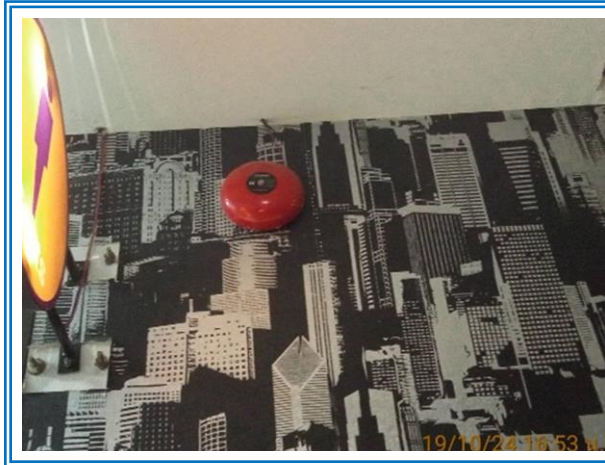
รูปที่ 3-38 (ต่อ) อุปกรณ์แจ้งเหตุเตือนภัยและระบบควบคุมการแจ้งเหตุเตือนภัย
