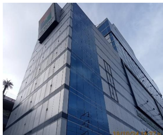
รูปที่ 3-29 ผนังแบบอลูมิเนียมคอมโพสิตและกระจกโพรทอปตัวอาคาร
